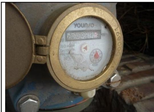
Foto No. 3 el sistema de medición se encuentra en la boca del pozo, en buenas condiciones.
